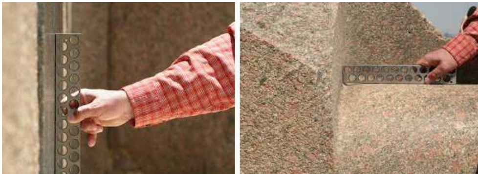
Rys. 1. Pomiar płaskości powierzchni płyt granitowych z Gizy [8]
